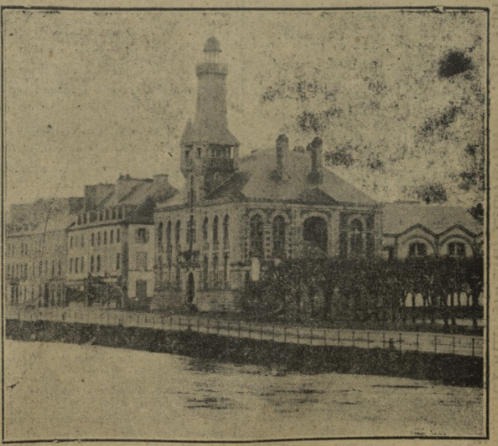
La nouvelle mairie de Châteaulin, que M. DUMESNIL, ministre de la Marine, inaugure aujourd'hui
